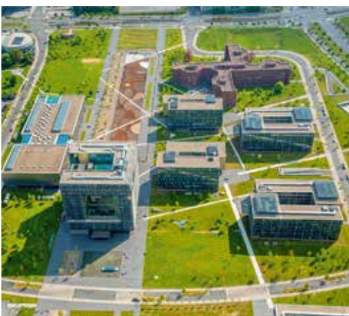
Das thyssenkrupp Quartier im Westviertel der Stadt
