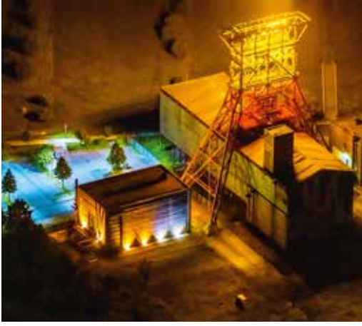
Fördergerüst Schacht IX mit den Maschinenhäusern Nord (I.) und Süd im Consol-Park, Gelsenkirchen
