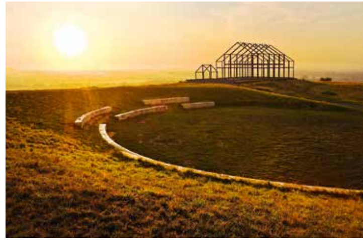
Hallenhaus auf der Halde Norddeutschland, Neukirchen-Vluyn Foto: Stefan Ziese
