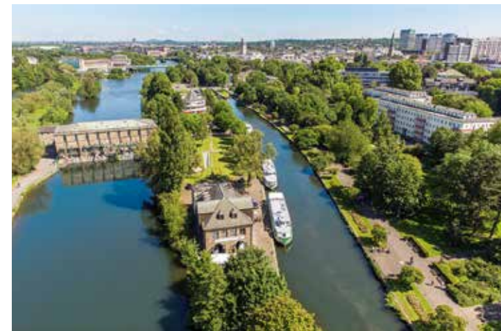
Wasserbahnhof, Wasserkraftwerk Kahlenberg und Haus Ruhrnatur, Mülheim an der Ruhr Foto: Jochen Tack
