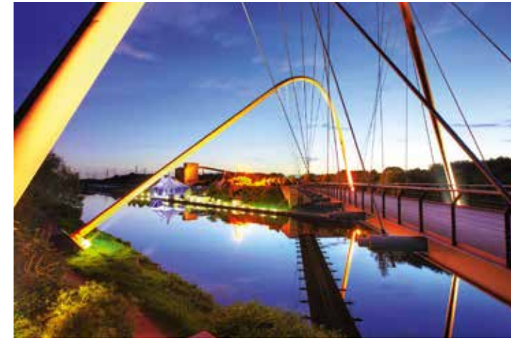
Doppelbogenbrücke über den Rhein-Herne-Kanal am Nordsternpark, Gelsenkirchen Foto: Jochen Tack
